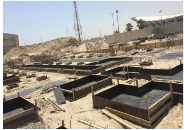
مبنى A في كلية البنات
